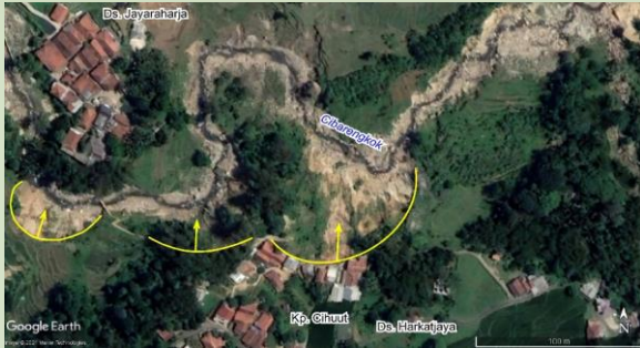
Lokasi gerakan tanah di Kp. Sihuat
