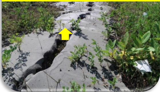
Keluarnya pasir atau semburan pasir dari bawah tanah
