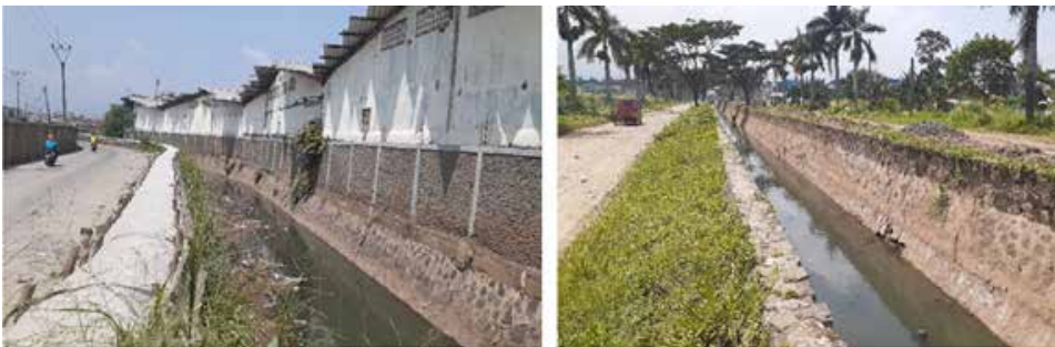
Gambar 8.7. Pembuatan tanggul-tanggul sementara dan drainase di daerah Kahatex untuk meminimalisir luapan Sungai Cikijing, namun banjir yang kerap terjadi dikarenakan jumlah air dari hulu sangat banyak tidak bisa tertampung oleh sungai-sungai sehingga meluap dan mengakibatkan banjir di jalan raya Bandung - Garut
