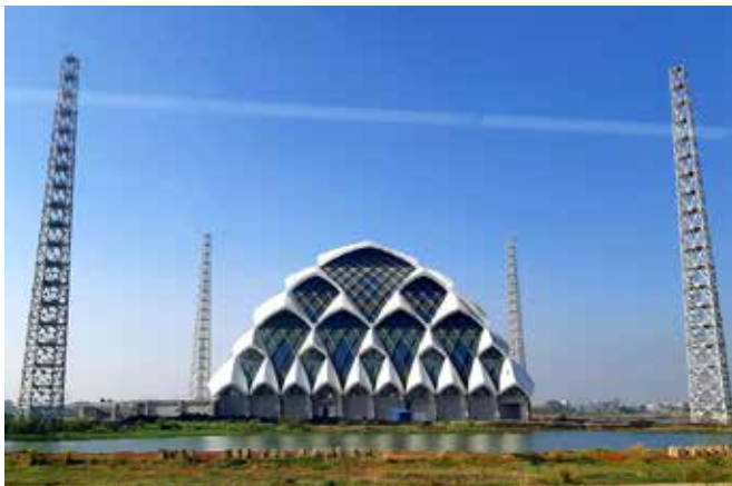
Gambar 1.31. Masjid Al Jabbar Gedebage "Landmark" baru Kota Bandung yang di bangun di lahan basah.
