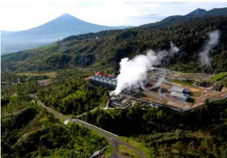
Gambar 10.13. PLTP Darajat yang berad di perbatasan Kabupaten Garut dan Kabupaten Bandung, Jawa Barat.
