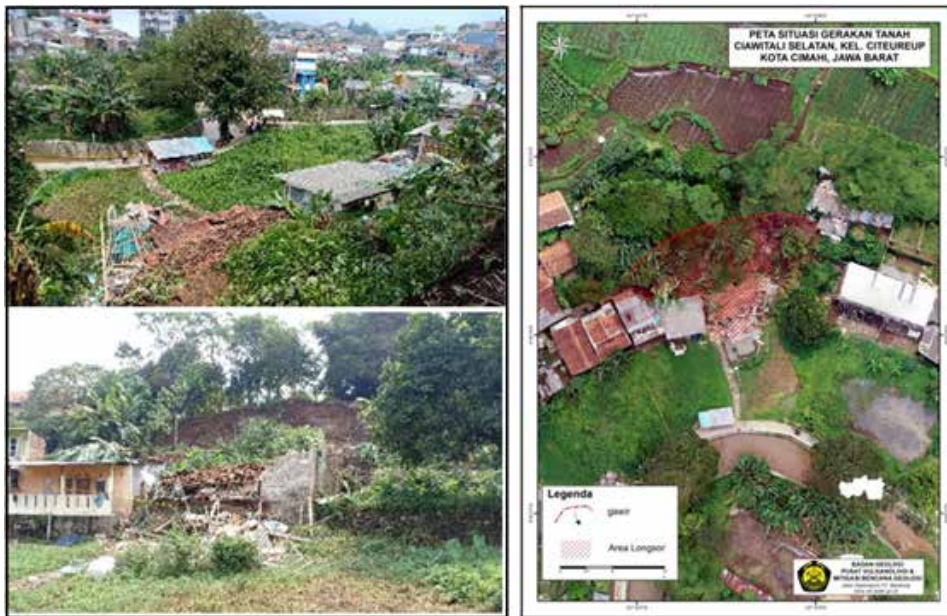
Gambar 1.25. Gerakan tanah tipe longsor bahan rombakan yang terjadi di areal pemukiman warga di Ciawitali Selatan, Kel. Citeureup Kota Cimahi.
