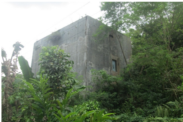
Foto 2.26. Bangunan sarang burung Walet di Atas Gua Walet
