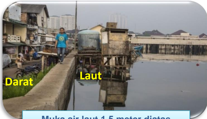
Muka air laut 1,5 meter di atas permukaan tanah Jakarta Utara
